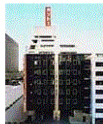
▲カントー本社ビル
