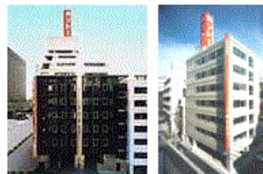
▲カントー本社ビル
